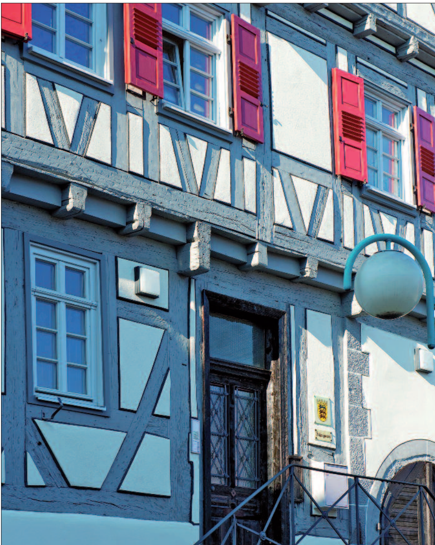
Ein Großteil der sanierungsfähigen Bausubstanz konnte erhalten werden.
