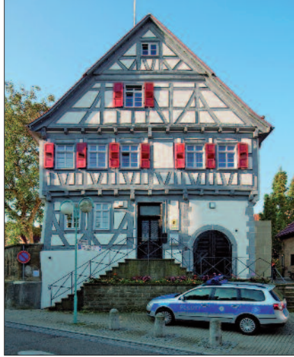
Die nördliche Giebelwand mit Sichtfachwerk
