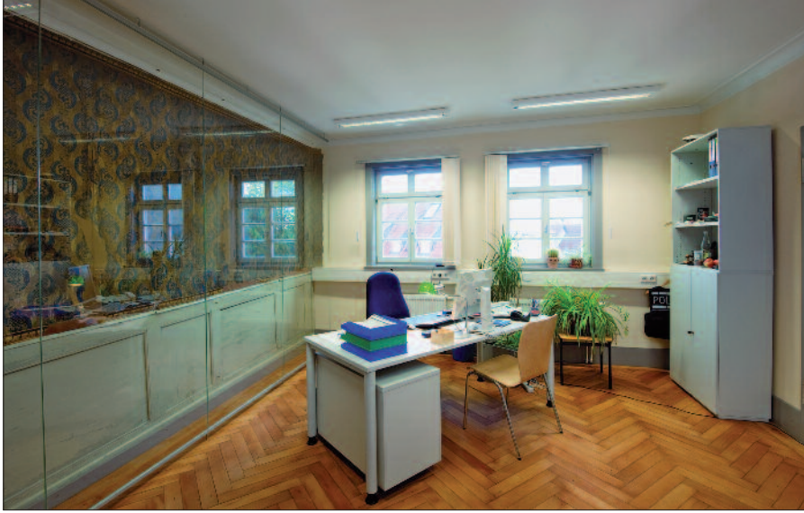
Der Giebel mit Sichtfachwerk wurde mit einer mineralischen Innendämmung gedämmt. (Fotos: Keimfarben)
