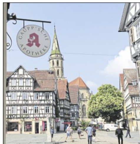
Sobald die Fassade saniert ist, werden die neuen Emaillieschilder wieder aufgehängt. Foto: Gamm
