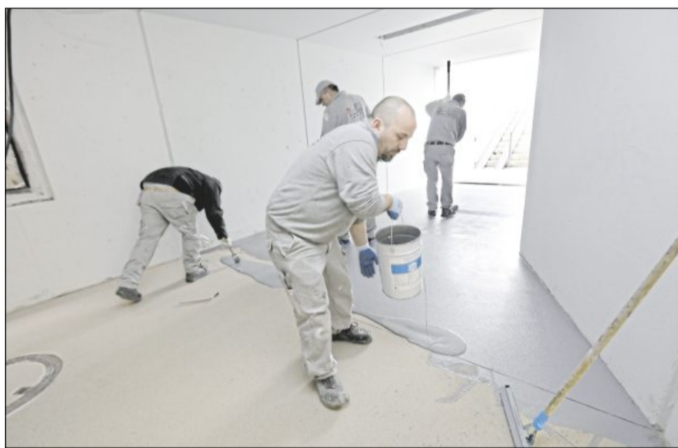
Auf den Boden ist ein neuer Kunstharzbelag aufgebracht worden.
