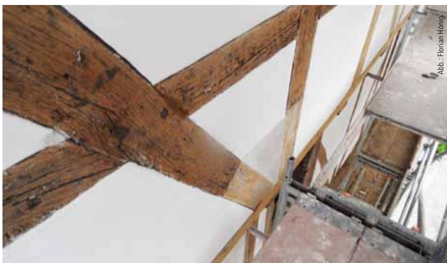
Abb. 8: Die angrenzenden Putzflächen dürfen beim Strahlen der Holzoberflächen nicht in Mitleidenschaft gezogen werden. Das Bild zeigt ein ordentliches Ergebnis ohne Beeinträchtigung von Rändern und Gefachflächen.
