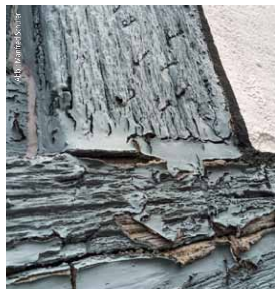
Abb. 5: Das Trocknungspotenzial darf sich durch eine Beschichtung nicht verschlechtern. Diese abplatzenden Farbschichten sehen zwar nicht schön aus, sind aber ein Glücksfall für die Hölzer. Eindringendes Wasser kann hier ungehindert wieder abtrocknen.
