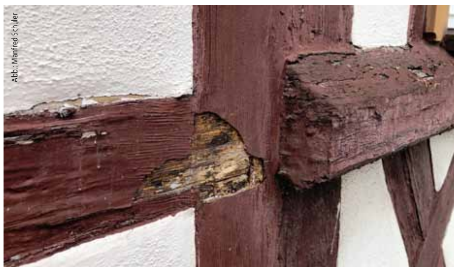
Abb. 12: Bei diesen mit Spachtelmasse überzogenen Hölzern führt die eindringende Feuchtigkeit zur Fäulnisbildung, da keine Rücktrocknungsmöglichkeit besteht.
