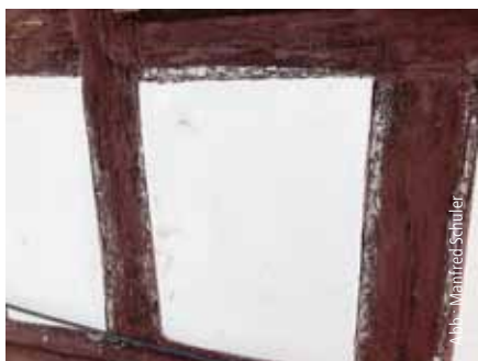
Abb. 13/14: Die Fugen zwischen Holz und Gefach sind sauber zu trennen und nicht zu überstreichen. Sonst sieht der Anschluss im Laufe der Zeit so un schön aus wie auf diesen Bildern.
