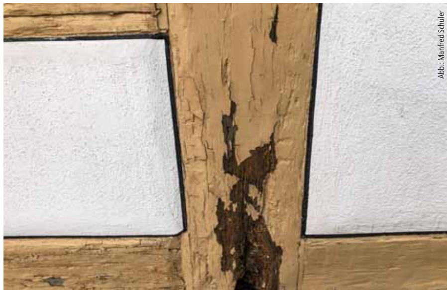
Abb. 11: Dieses Bild von 2020 bestätigt die Befürchtung. Mittlerweile ist die Spachtelmasse abgefallen, da der Untergrund durch Fäulnis abgängig ist.
