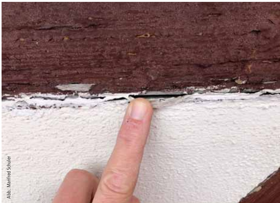
Abb. 15: „Dauerelastische Dichtstoffe“ sind bei den Bewegungen von Fachwerkhäusern auf Dauer weder schön, noch erfüllen sie ihren angedachten Zweck.
