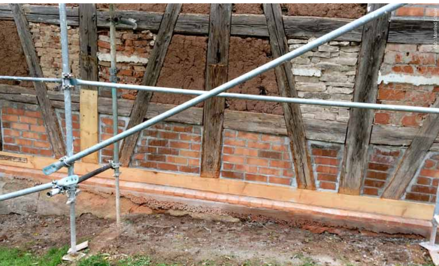
Abb. 1: Bestehendes Sichtfachwerk ist in jeder Hinsicht eine Mischbauweise, zum einen zwischen Holzfachwerk und Gefach, hier aber auch der Wechsel in der Gefachfüllung und die Unterschiede zwischen alten und Ausbesserungshölzern.
