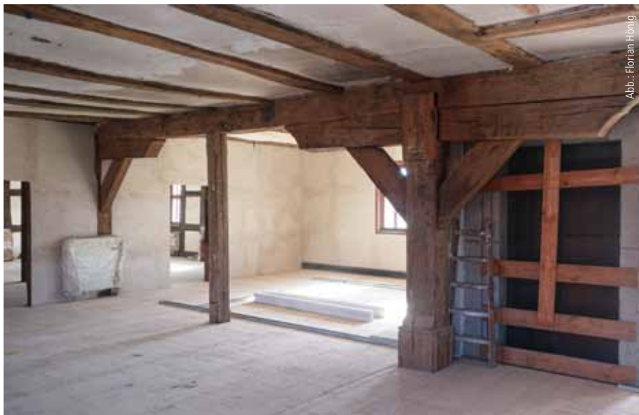
Abb. 6: Richtig ausgeführt, lassen sich Holzoberflächen sauber und ordentlich abstrahlen.
