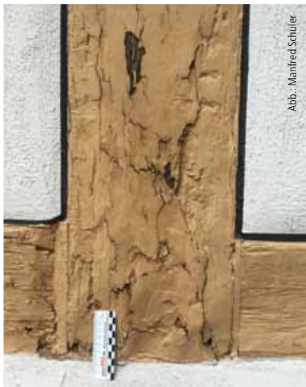
Abb. 10: Ein Stützenfuß mit flächiger Epoxidharzspachtelmasse auf einem ohnehin kritischen Sockelanschluss: Hier ist im Jahr 2017 zwar noch kein Schaden zu sehen, aber er wird wahrscheinlich nicht ausbleiben.
