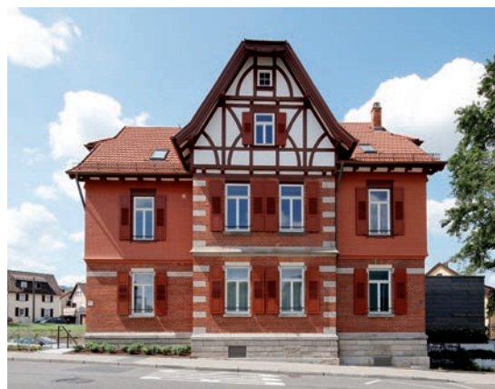
Die denkmalgeschützte Villa nach der fachgerechten Sanierung
